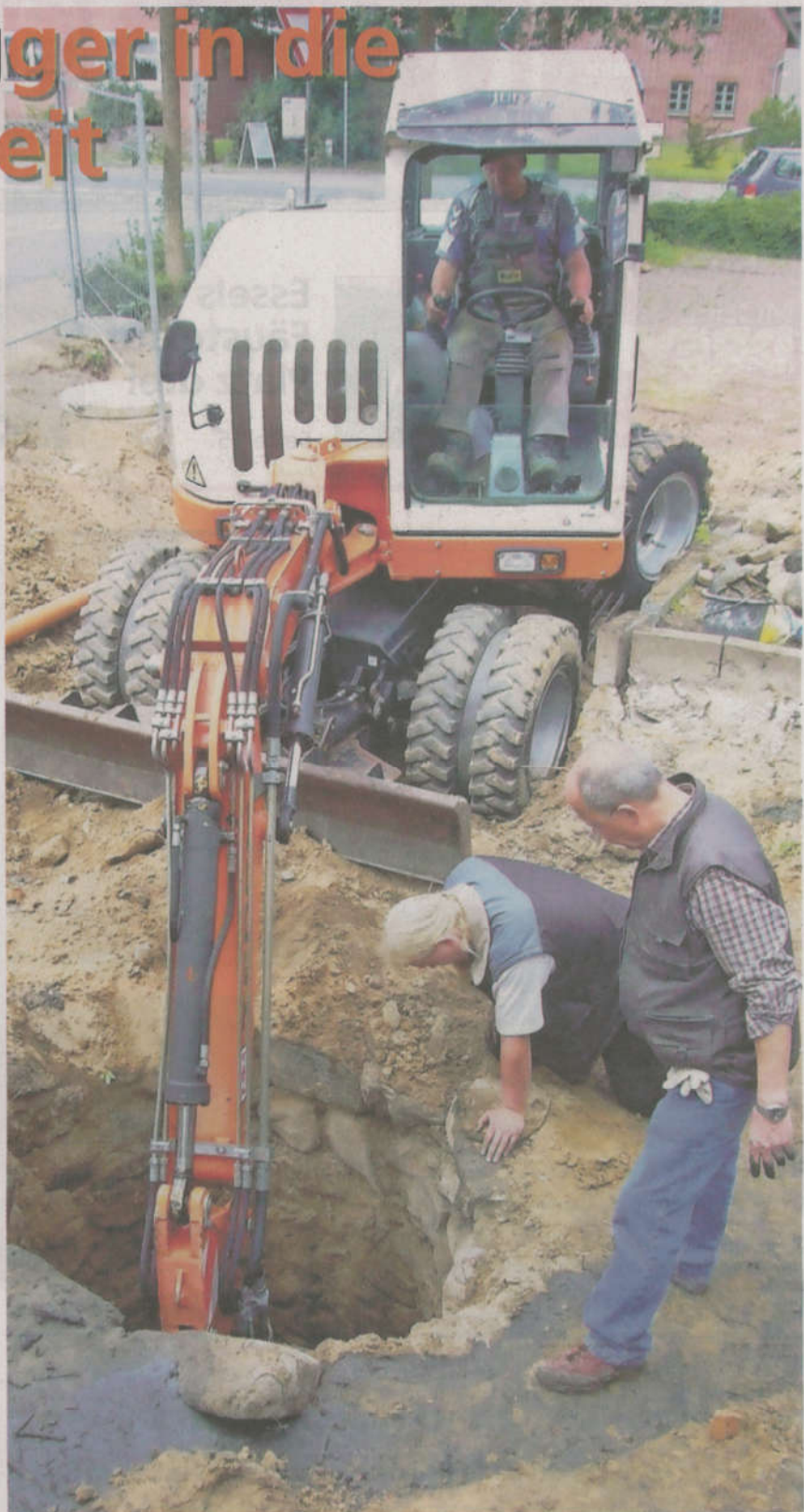
Mit dem Bagger wird der Bliedersdorfer Brunnen geleert.
